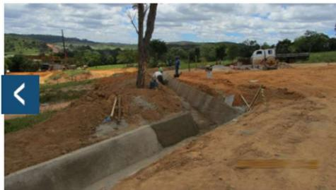
Execução de drenagem na crista do talude.
