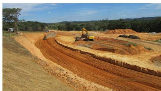
Escavadeira realizando desmonte de talude para ser lançado ao estoque de argila.
